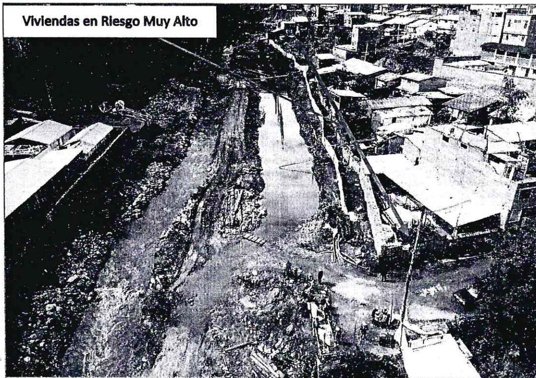
**Imagen 35:** fotografía aérea (Drone), trabajos inundados en el momento de la crecida, viviendas aledañas en riesgo en el Tramo III, Ciudad de Lircay (Río Sicra). Fuente: Equipo técnico GRD.
