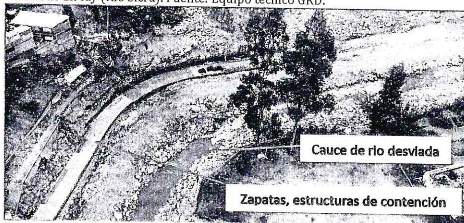
**Imagen 18:** fotografía aérea (Drone) 22 de noviembre, trabajos avanzados, en tramos de conformación de zapatas, Ciudad de Lircay (Rio Sicra). Fuente: Equipo técnico GRD.
