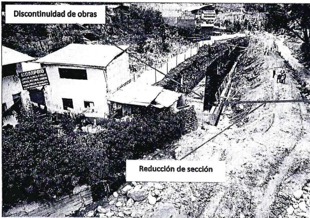
**Imagen 40:** fotografía aérea (Drone), en el inicio del tramo III denominado, se ejecutan obras con discontinuidad de sección, Ciudad de Lircay (Rio Sicra). Fuente: Equipo técnico GRD.
