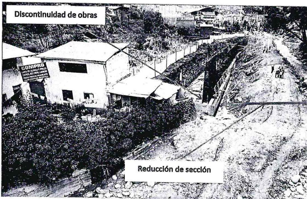
Imagen 47: fotografía aérea (Drone) 22 de noviembre, en el inicio del tramo III denominado, se ejecutan obras con discontinuidad de sección, Ciudad de Lircay (Rio Sicra). Fuente: Equipo técnico GRD.
