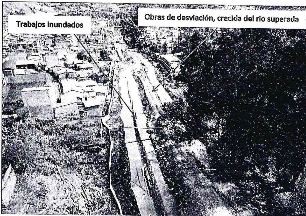
**Imagen 36:** fotografía aérea (Drone), trabajos inundados en el momento de la crecida, obras de desviación con problemas de filtración por la crecida del rio Sicra, Ciudad de Lircay (Rio Sicra).
