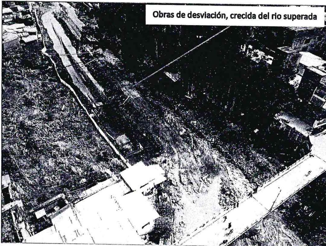
**Imagen 36:** fotografía aérea (Drone), trabajos inundados en el momento de la crecida, obras de desviación con problemas de filtración por la crecida del rio Sicra, Ciudad de Lircay (Rio Sicra).
