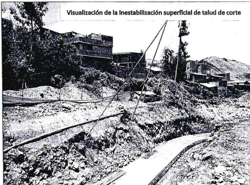
**Imagen 39:** fotografía aérea (Drone), talud de corte requieren apuntalamiento, se visualiza su inestabilidad superficial, Ciudad de Lircay (Rio Sicra). Fuente: Equipo técnico GRD.
