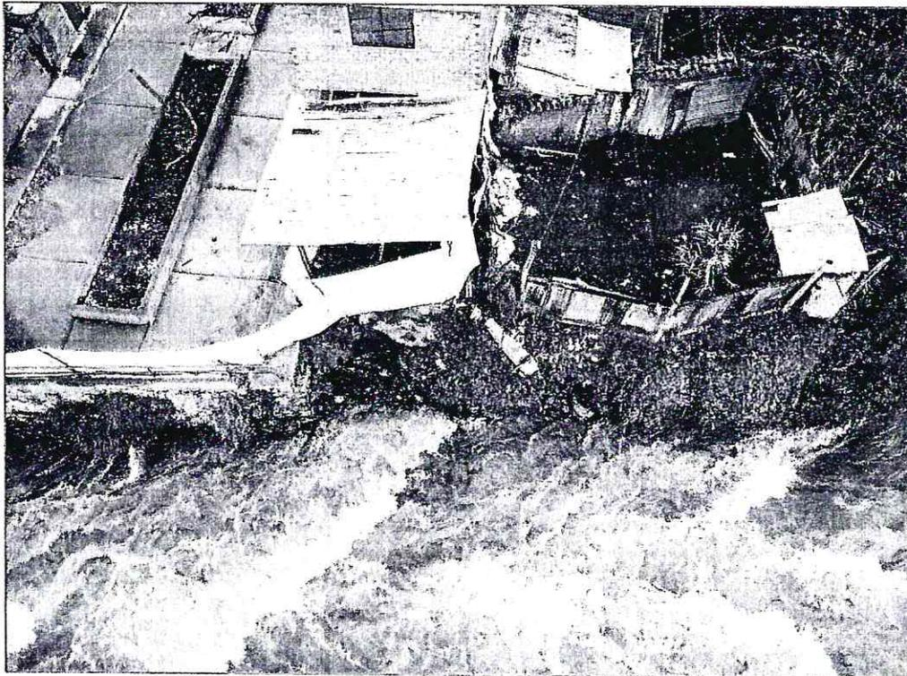
**Imagen 51:** fotografía aérea (Drone) 19 de diciembre, viviendas en riesgo a colapsar, talud de rivera en erosión por crecida y erosión fluvial, Ciudad de Lircay (Rio Sicra). Fuente: Equipo técnico GRD.
