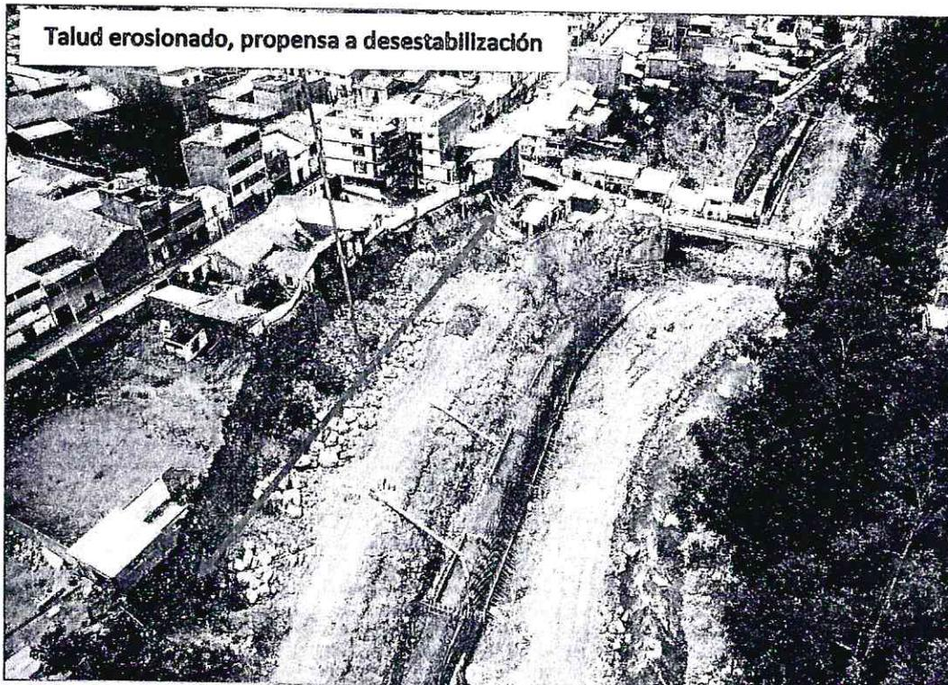
**Imagen 37:** fotografía aérea (Drone), trabajos de conformación de estructuras de contención, cortes y excavación al pie de viviendas aledañas, por seguridad requiere apuntalamiento el talud erosionado por el rio, Ciudad de Lircay (Rio Sicra). Fuente: Equipo técnico GRD.
