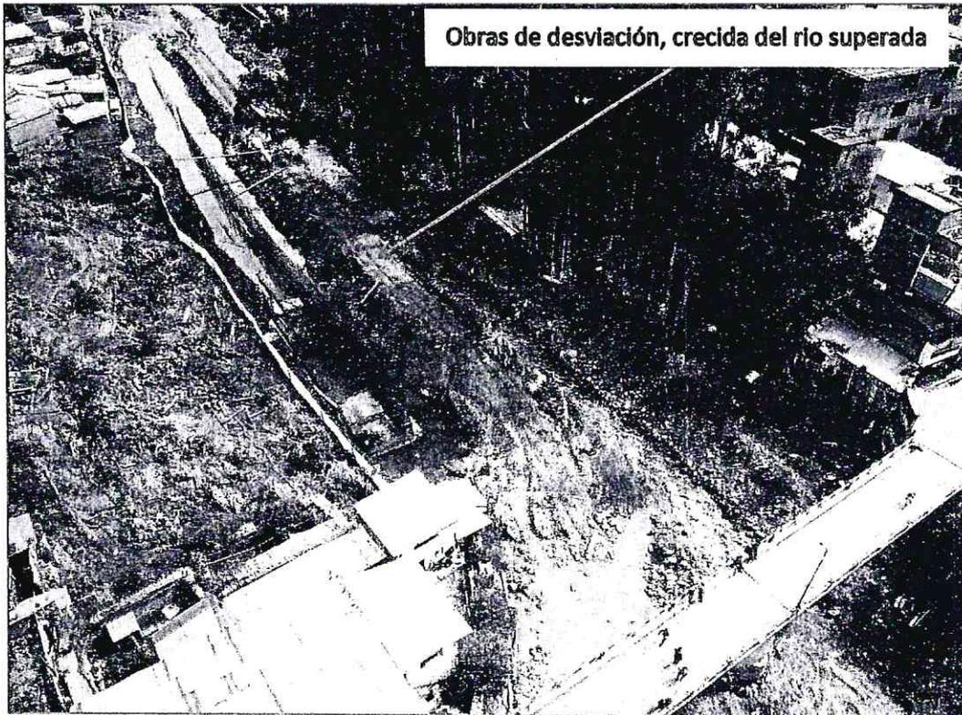
**Imagen 41:** fotografía aérea (Drone) 22 de noviembre, trabajos inundados en el momento de la crecida, obras de desviación con problemas de filtración por la crecida del rio Sicra, Ciudad de Lircay (Rio Sicra). Fuente: Equipo técnico GRD.
