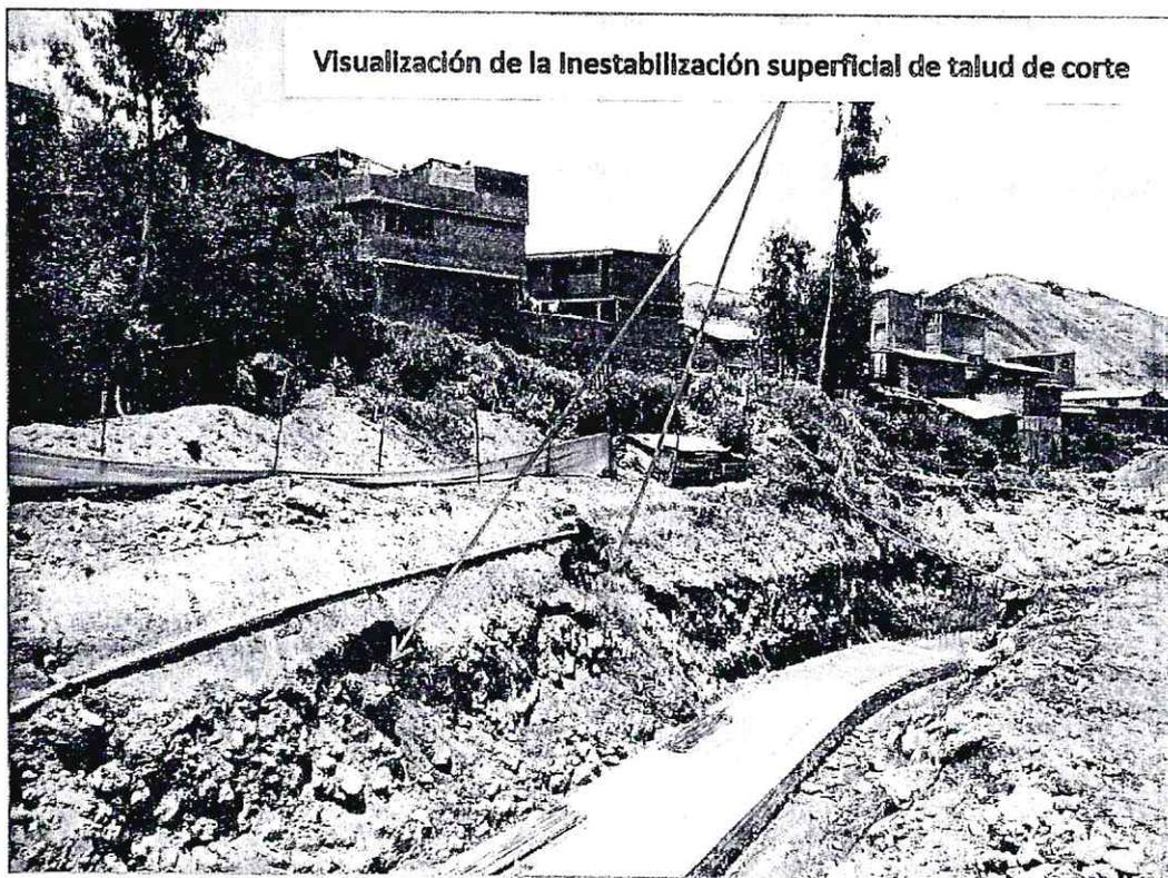
**Imagen 46:** fotografía aérea (Drone) 22 de noviembre, talud de corte requieren apuntalamiento, se visualiza su inestabilidad superficial, Ciudad de Lircay (Rio Sicra). Fuente: Equipo técnico GRD.
