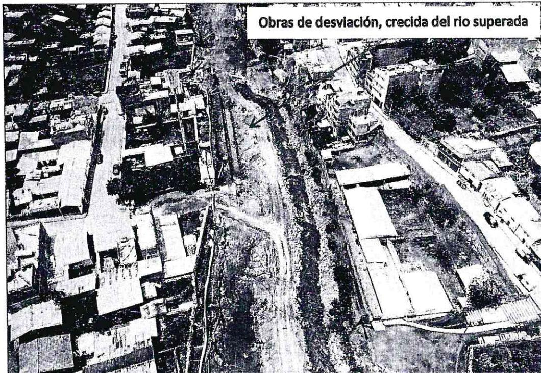
**Imagen 38:** fotografía aérea (Drone), trabajos inundados en el momento de la crecida, obras de desviación con problemas de filtración por la crecida del rio Sicra, Ciudad de Lircay (Rio Sicra). Fuente: Equipo técnico GRD.
