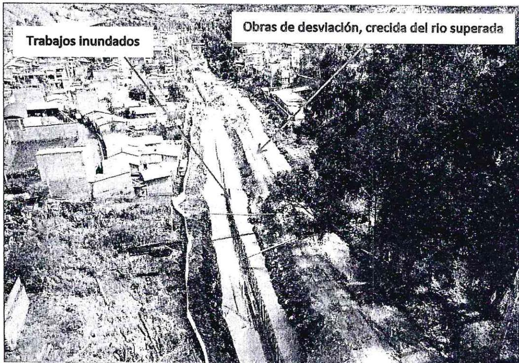
**Imagen 42:** fotografía aérea (Drone) 22 de noviembre, trabajos inundados en el momento de la crecida, obras de desviación con problemas de filtración por la crecida del rio Sicra, Ciudad de Lircay (Rio Sicra). Fuente: Equipo técnico GRD.
