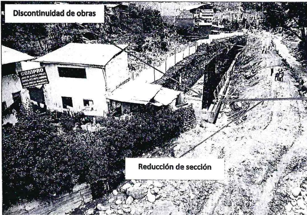
**Imagen 47:** fotografía aérea (Drone) 22 de noviembre, en el inicio del tramo III denominado, se ejecutan obras con discontinuidad de sección, Ciudad de Lircay (Río Sicra). Fuente: Equipo técnico GRD.
