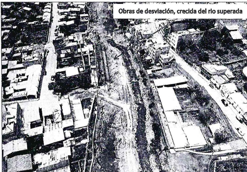
**Imagen 45:** fotografía aérea (Drone) 22 de noviembre, trabajos inundados en el momento de la crecida, obras de desviación con problemas de filtración por la crecida del rio Sicra, Ciudad de Lircay (Rio Sicra). Fuente: Equipo técnico GRD.
